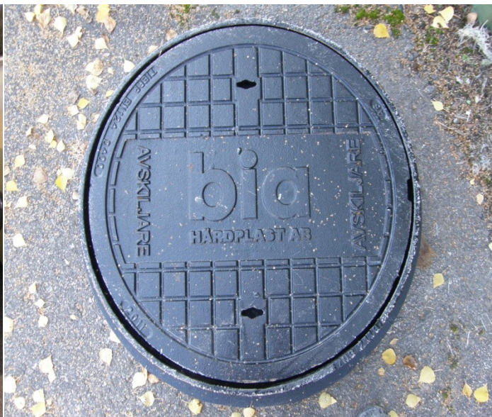
Bilden visar en fast A6 gjutjärnsbetäckning
